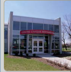
Centre civique Bernard-Gagnon 6, rue Bella-Vista
